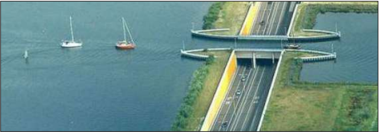
fig. 09 - Ponte canal, Holanda. Fonte: (GMF, 2011)
