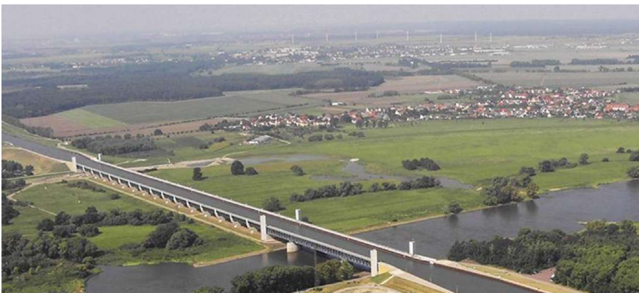
fig. 14 -Ponte fluvial Magdeburg, Alemanha. Fonte: (GMF,2011)
