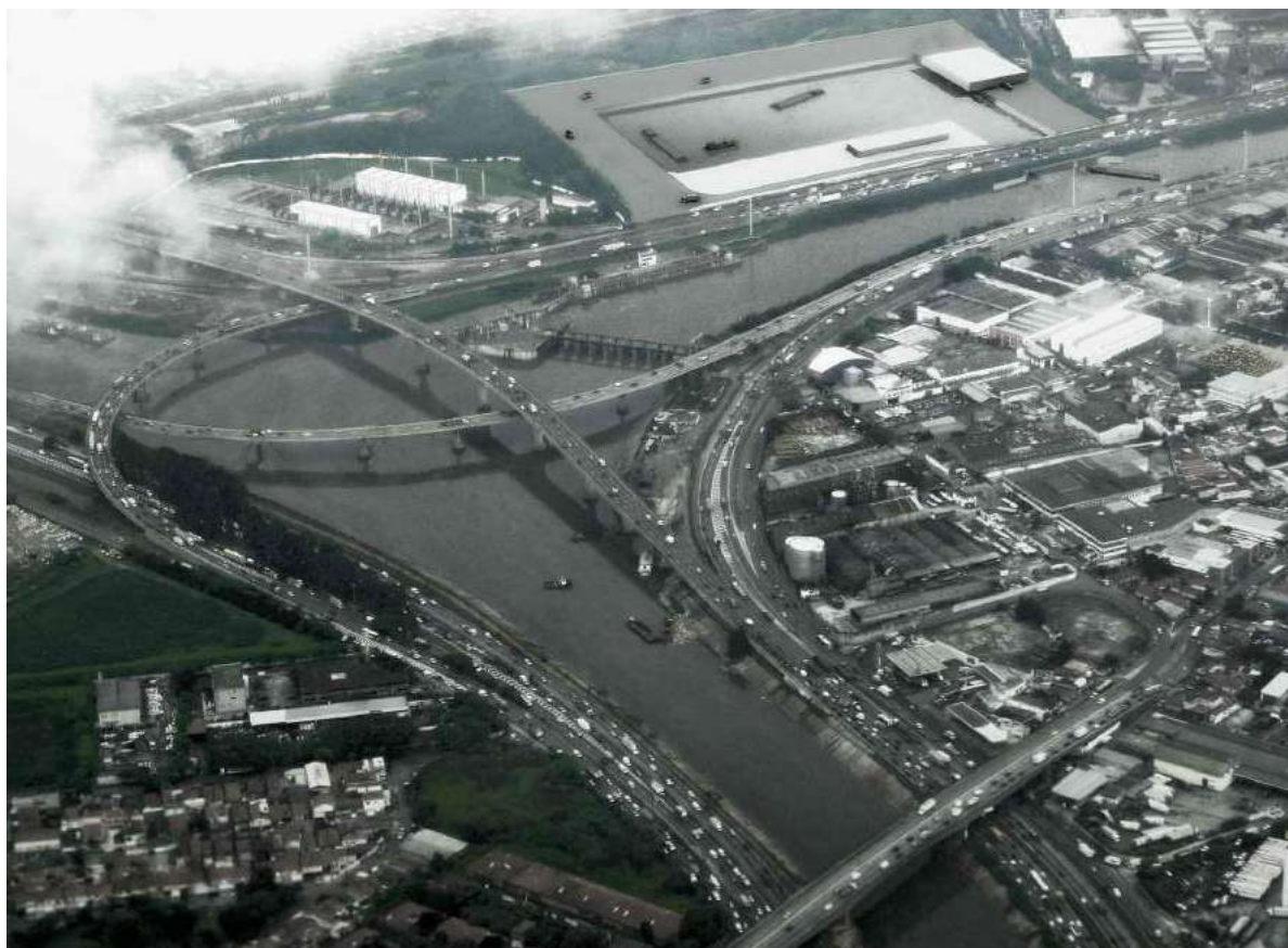
fig. 112 - Barragem/Eclusa do Cebolão. Fonte: GMF
