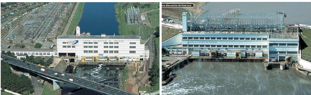
fig. 79 e 80- Barragens de Traição e Pedreira (destaque para os acessos às camaradas eclusas). Fonte: (FAT, 2004)
