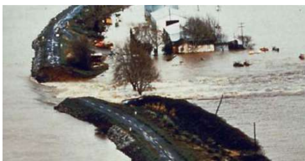
fig. 16 - Ruptura de dique, Holanda Fonte: (GMF, 2011)
