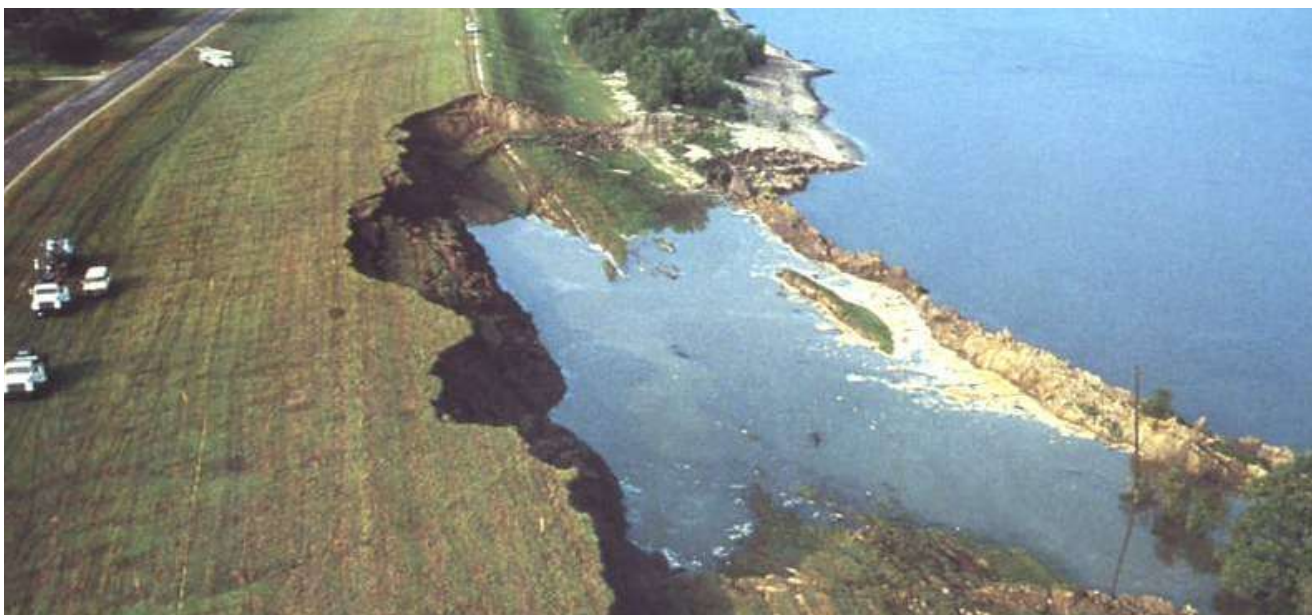
fig. 15 - Ruptura do dique de Marchland, Los Angeles Fonte: (GMF, 2011)
