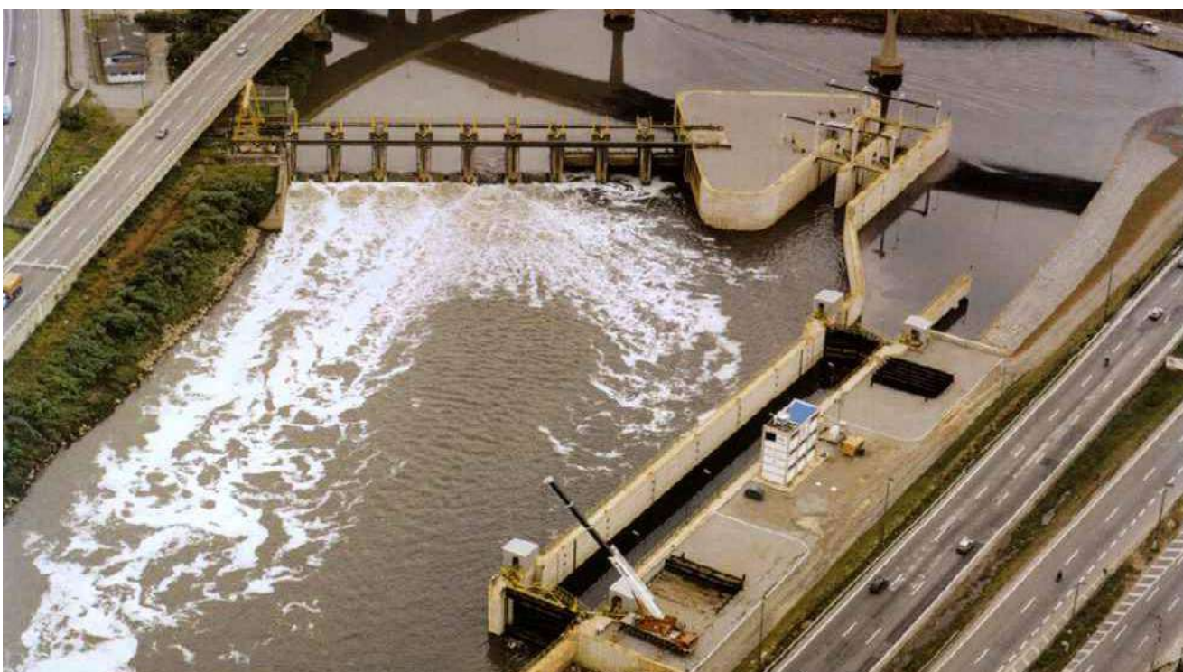
fig. 81 - Barragem móvel do cebolão com eclusa. Fonte: (FAT, 2004)
